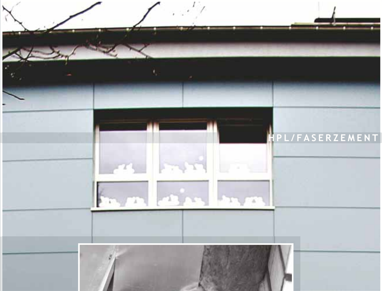
Saniertes Schulgebäude mit HPL Fassade
